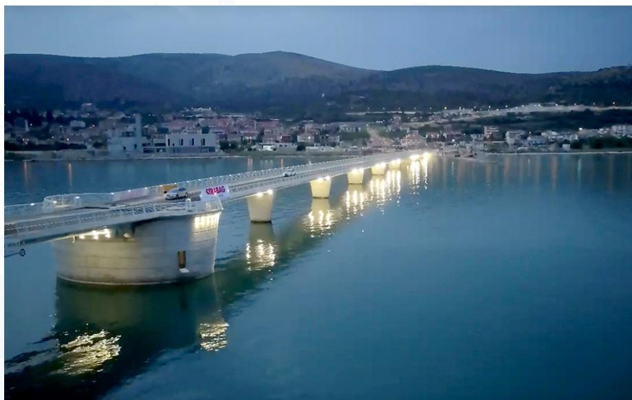
Novi most Čiovo - kopno je pokretni gredni most sa čeličnim rasponskim sklopom ukupne duljine 546,34 m
